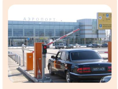
Вместе со шлагбаумом в системе используются ИК-датчик, предназначенные для предотвращения опускания стрелы шлагбаума на автомобиль. Пары используются для предотвращения замыкания сигнала на транспорте со сложной геометрией (Например разрыв между кабиной и кузовом грузового автомобиля).
